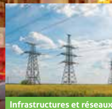
Infrastructures et réseaux
